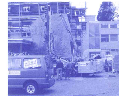
Erdsondenbohrung mit einer Tiefe von 2 x 210 Metern.
