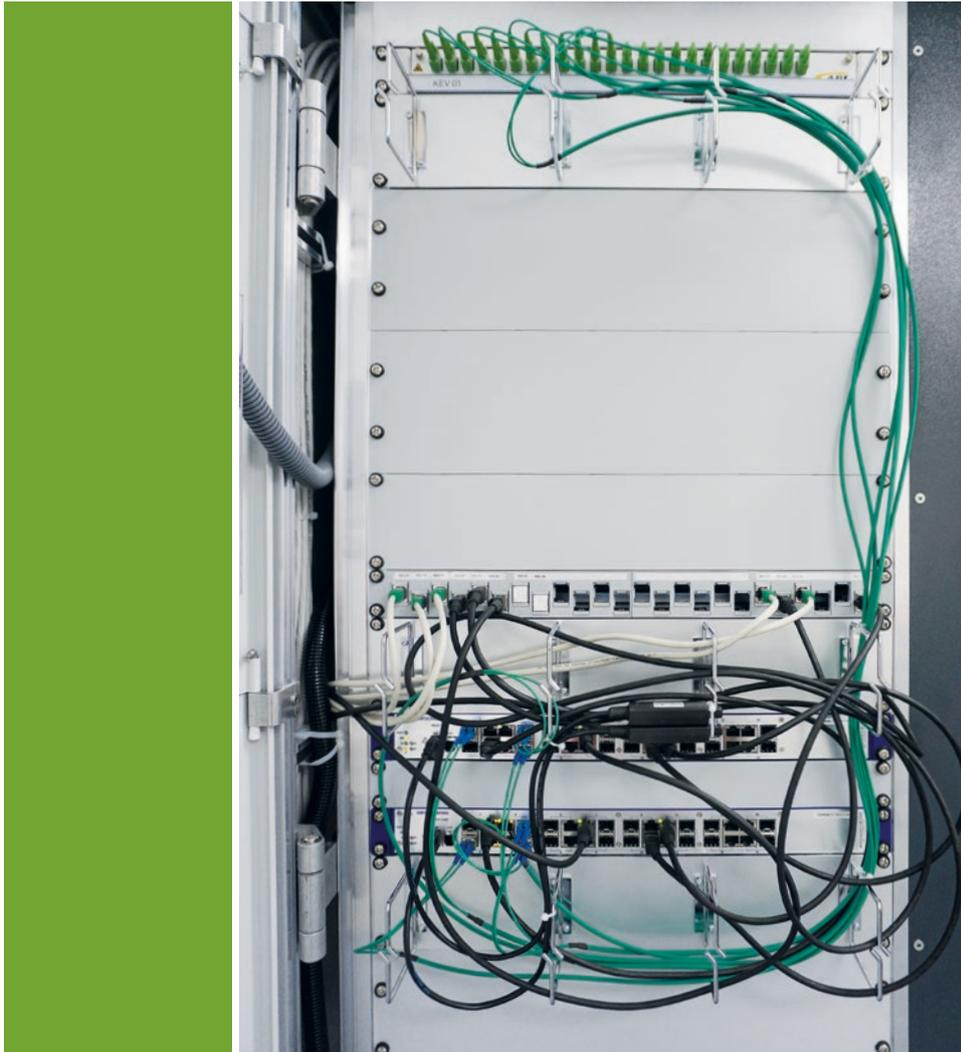
Verteilerschrank mit LWL-Rack, Switches und Patchkabel für das technische Netzwerk.
