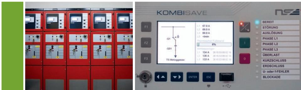
Mittelspannungsschaltanlage mit den neuen Schutzgeräten NSE Kombisave.
