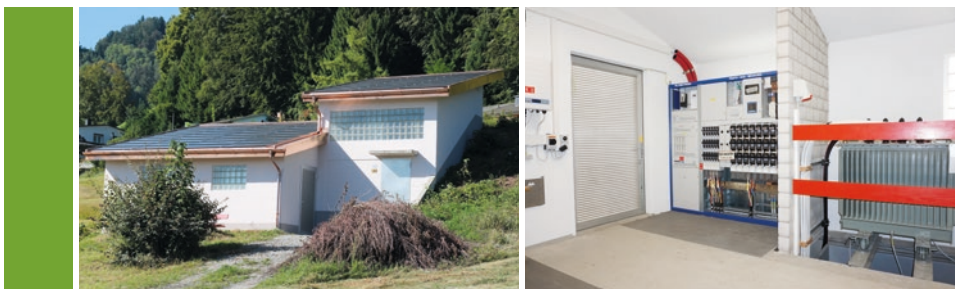
Photovoltaikanlage (Bild links).
