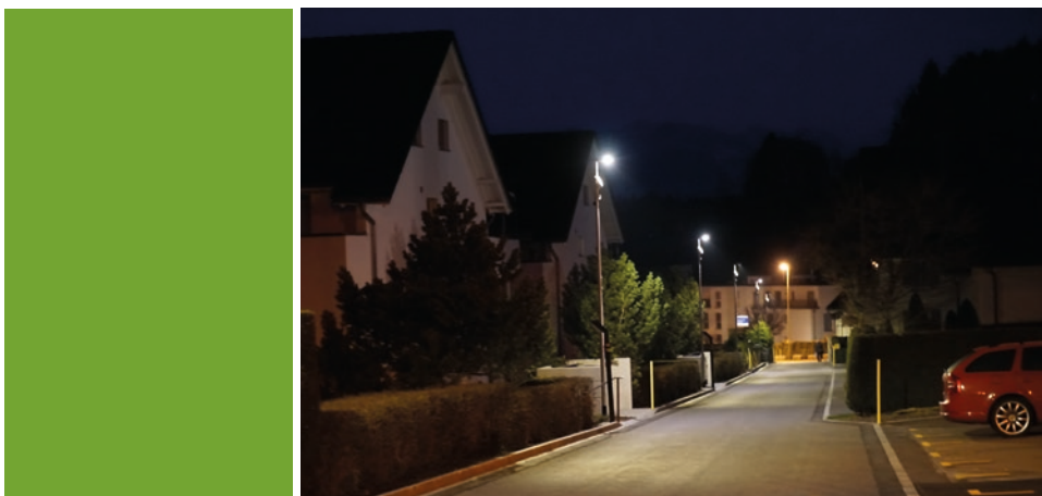
Moderne, energieeffiziente Strassenbeleuchtung an der Mürtschenstrasse.
