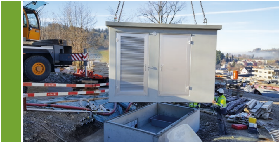
Stellen der Transformatorstation mit Pneukran.
