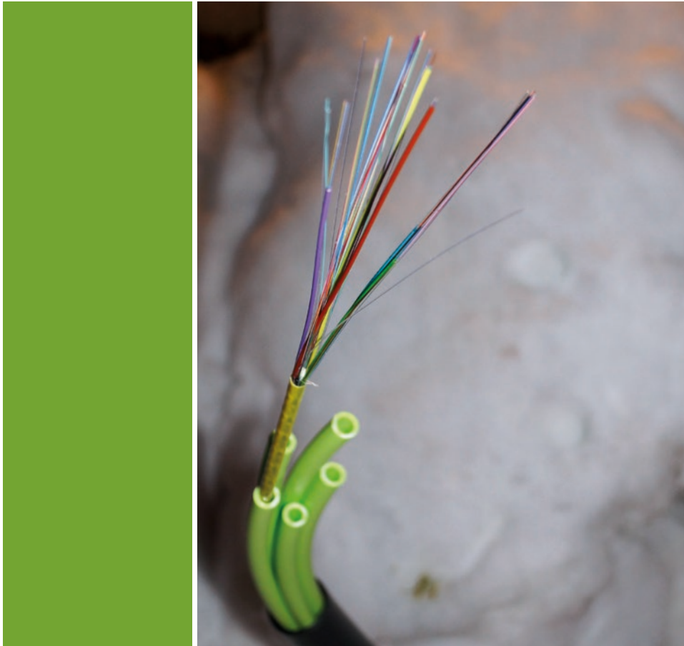
Einzug von Riefenrohr und Einblasen von LWL-Kabel.
