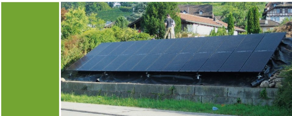
Böschungsanlage in Jona.
