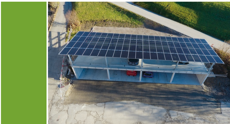
Anlage auf Carport mit bifacialen Modulen.
