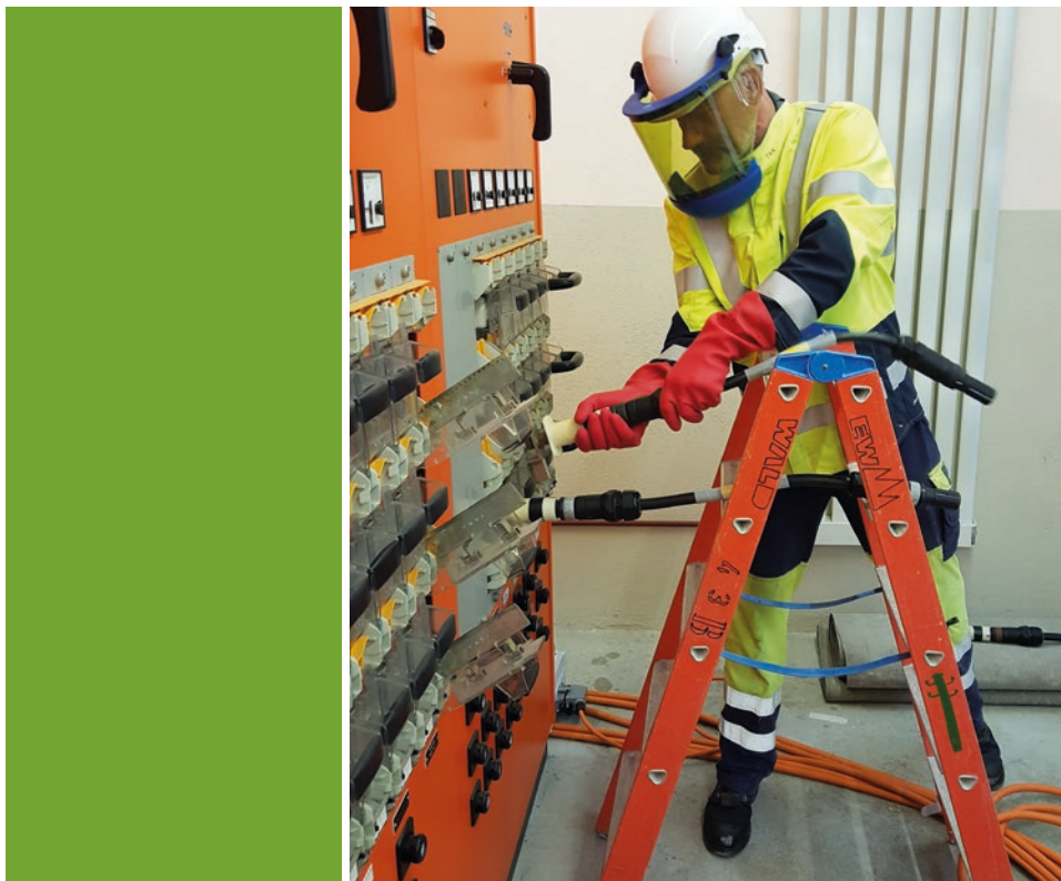
Mitarbeiter bei der Arbeit unter Spannung (AuS).
