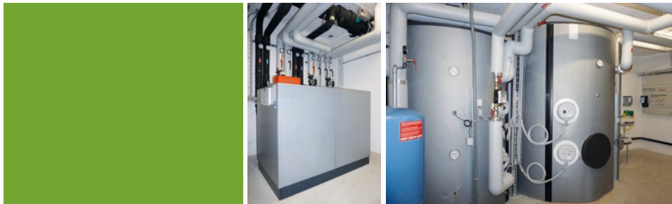
Wärmepumpenanlage MFH Jonagarten.
