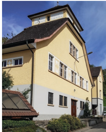
Trafostation Messstation, Aussensanierung, Gebäude erstrahlt in neuem Glanz.
