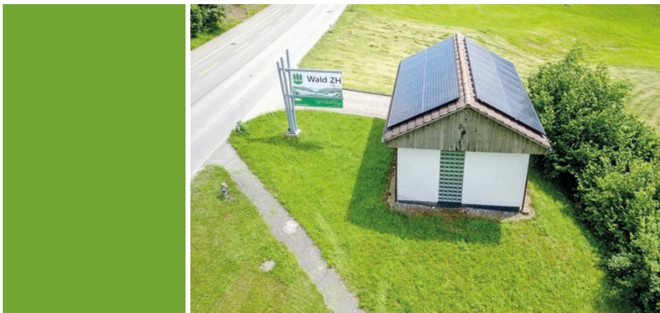
Trafostation Winkel, Sanierung und Aufbau einer Photovoltaikanlage mit 11 kW Leistung.
