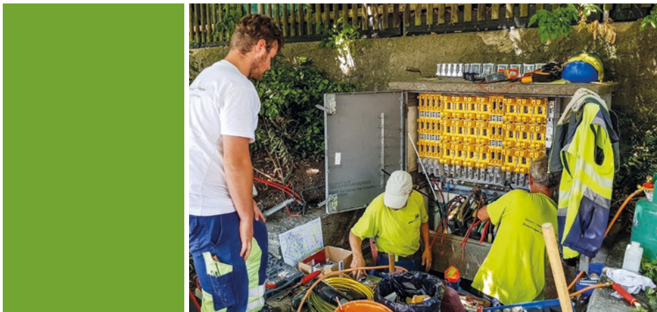
Sanierung der Verteilkabine an der Unterpuntstrasse.
