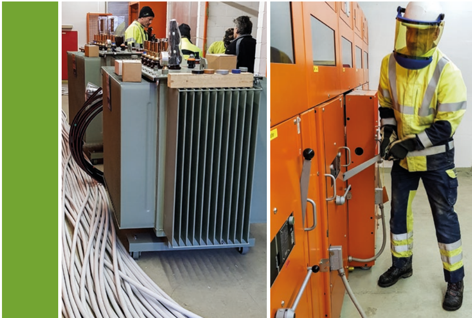
TS Felsenau, Ersatz der Transformatoren und Neuverkabelung (Bild links).
