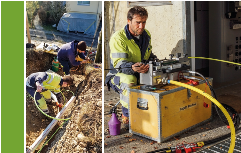
Mitarbeiter des Netz-Teams beim Einzug von Riefenrohr zur späteren Nutzung von Glasfaserkabeln (Bild links).
