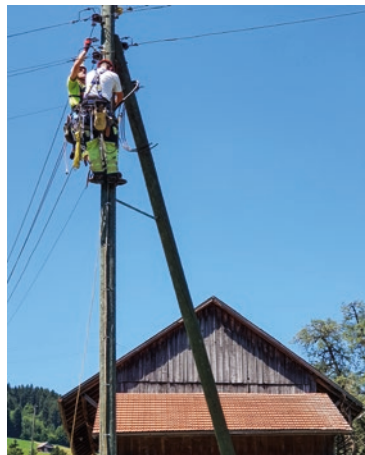
Verkabelung Tösstalstrasse – Dieterswil: Anpassungsarbeiten an der Freileitung.
